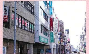
旧甲州街道沿い明治安田生命調布ビルの5階。
